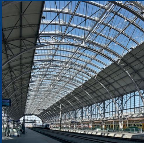
Rekonstrukce zastřešení Hl. nádraží Praha
