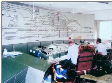
Obr. 24 Ústřední stavědlo v ŽST Česká Třebová (reprodukce z archivu)
