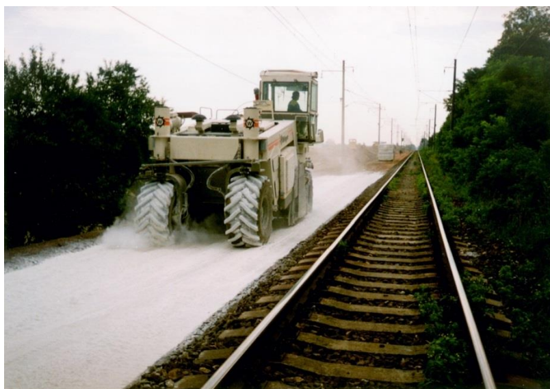
Obr. 7 Stabilizace vápnem na trati Poříčany - Kolín
