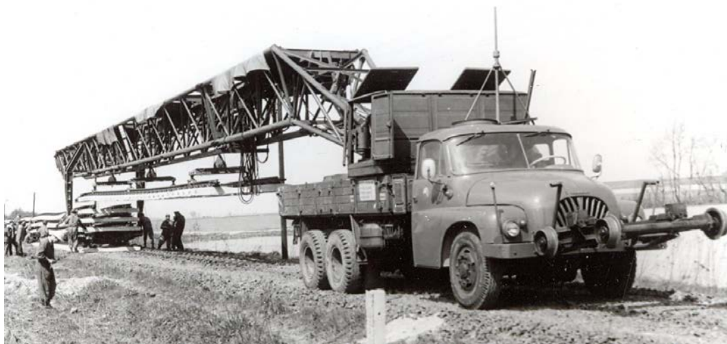
Obr. 5 Pokladač PKP 25/20 se osvědčil a v dalších verzích se používá do současnosti. Sběrka Hynek Krejčí.
