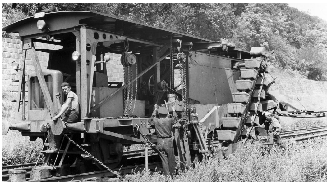
Obr. 2 Čističky švýcarské firmy Scheuchzer typ A byly prvními u ČSD. Sbirka Josef Valeš.
