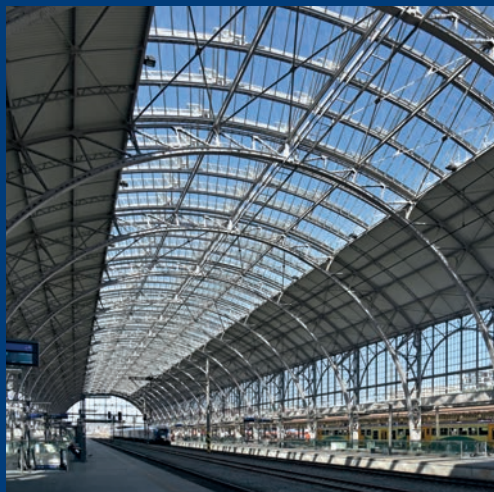
Rekonstrukce zastřešení Hl. nádraží Praha
