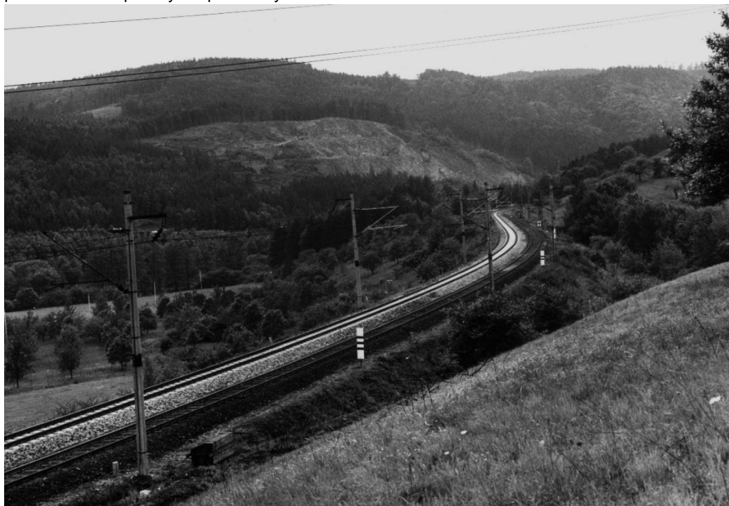
Obr. 4 Nová traťová kolej Havlíčkův Brod – Brno
