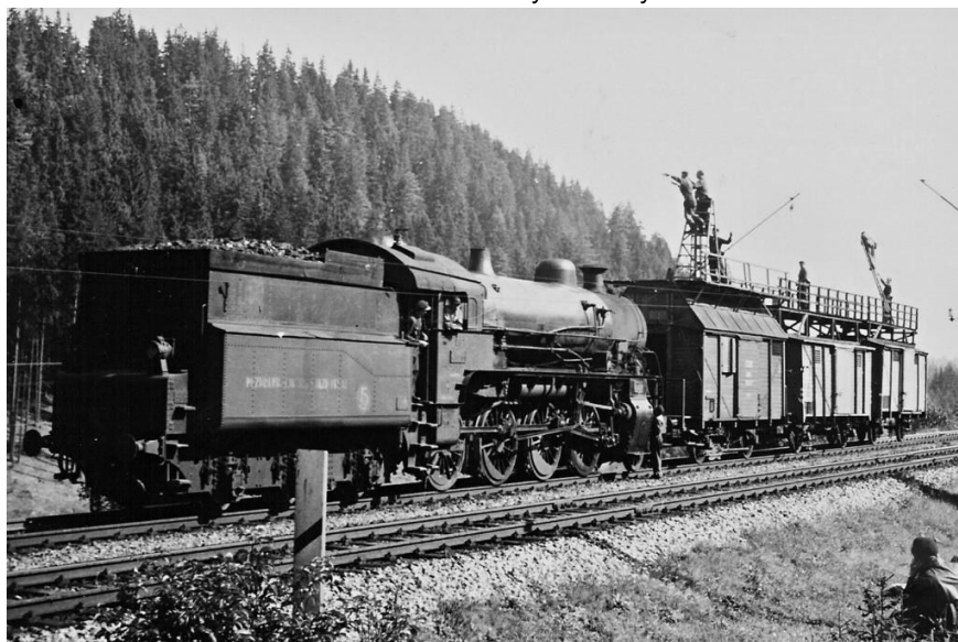
Obr. 5 Montážní vlak Elektrizace železnic
