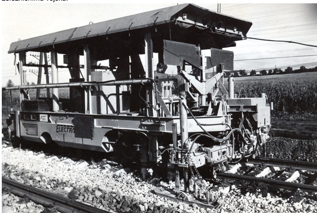
Obr. 4 Traťové ASP kanadské firmy Tamper byly na našich tratích provozovány především železničním vojskem. Sbíрка Hynek Krejčí.
