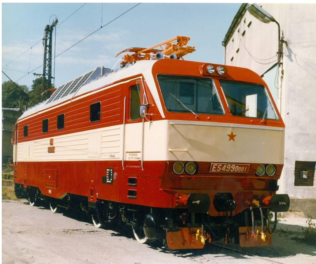
Obr. 22 Prototyp elektrické lokomotivy ES 499.0001 pro rychlost 200 km/h ve výrobním závodě v roce 1973
