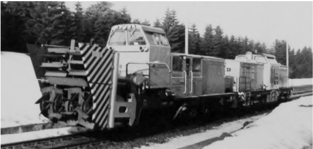
Obr. 6 Sněhová fréza KSF 80 byla výsledkem spolupráce ČSD a DR. Archiv MTH Praha.
