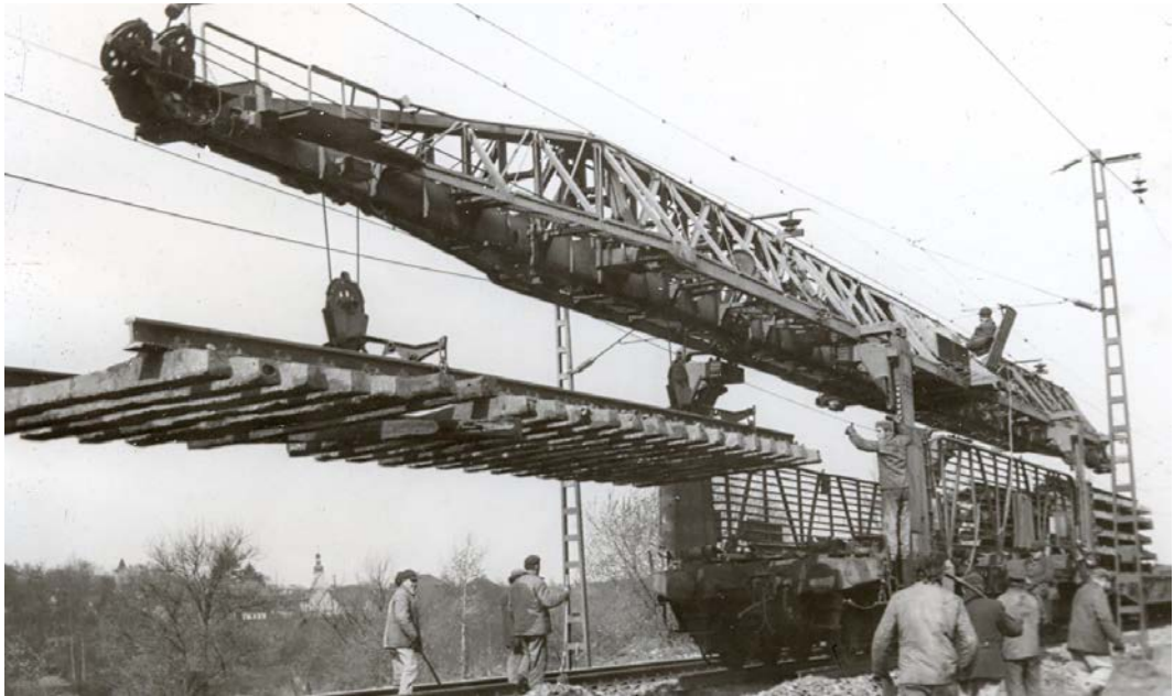
Obr. 3 Kladecí jeřáby UK 25/9 dovážené ze SSSR od roku 1961 představovaly kvalitativní pokrok při obnovách železničního svršku. Sbirka Hynek Krejčí.
