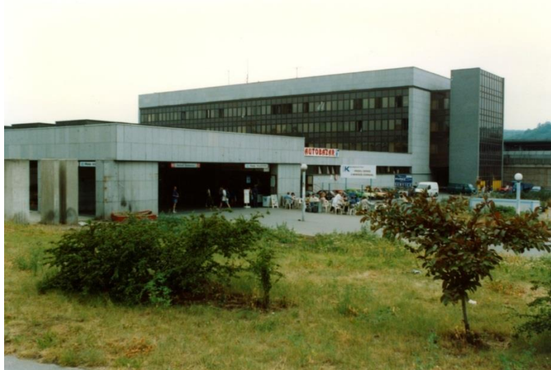
Obr. 2 Výpravní budova Praha Holešovice
