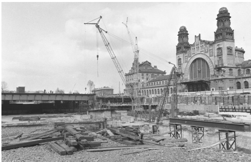
Obr. 3 Praha hl.n. výstavba nové odbavovací haly, 70.léta 20.století
